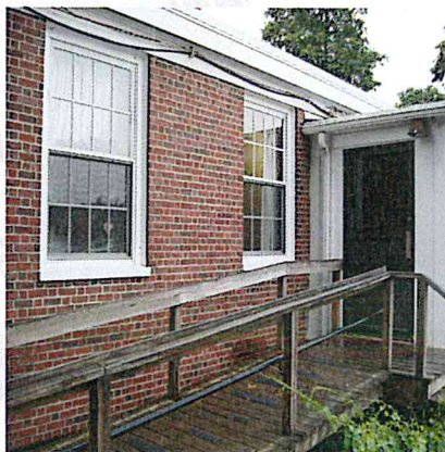
ADA Compliant rear door 1982
